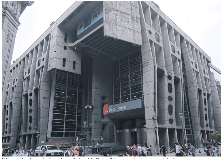
El Banco de Londres pretendía que la arquitectura del edificio reflejara su reputación de integridad y eficiencia
